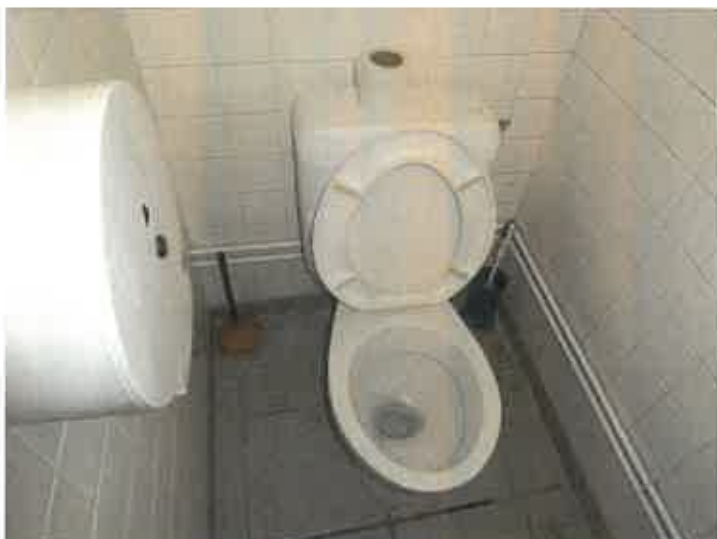
Un cabinet d'aisance avec réservoir dorsal, abattant et lunette. Un dévidoir de papier hygiénique sur le pan de mur accueillant la porte d'accès.
