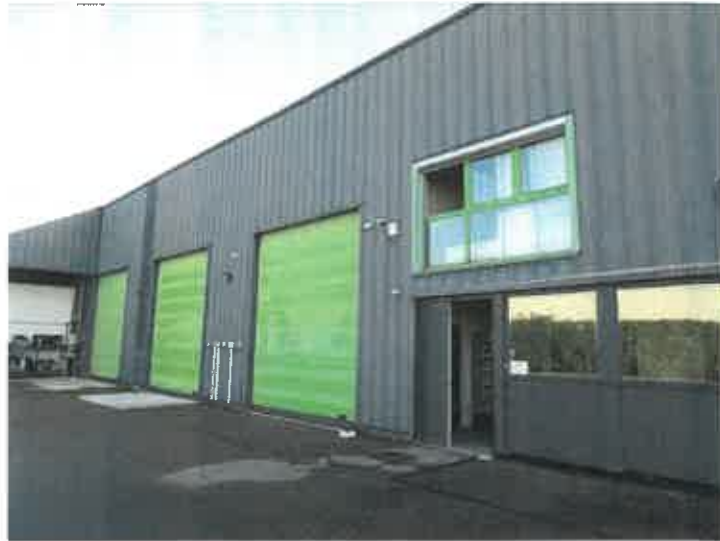
En partie fond, un hangar sur piliers de soutènement métallique avec bardage métallique. A cet endroit, le module local lave chariot décrit par la suite.
