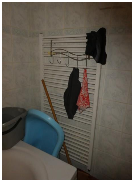
Encastré, un bloc de ventilation mécanique contrôlée.
