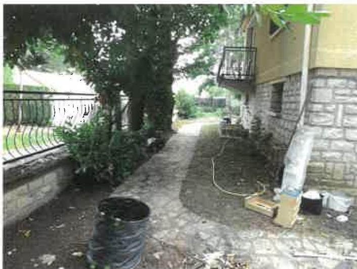
Les façades et murs pignons de la maison sont composés de pierres jointoyées en partie basse et recouvertes d'un enduit en partie haute.
