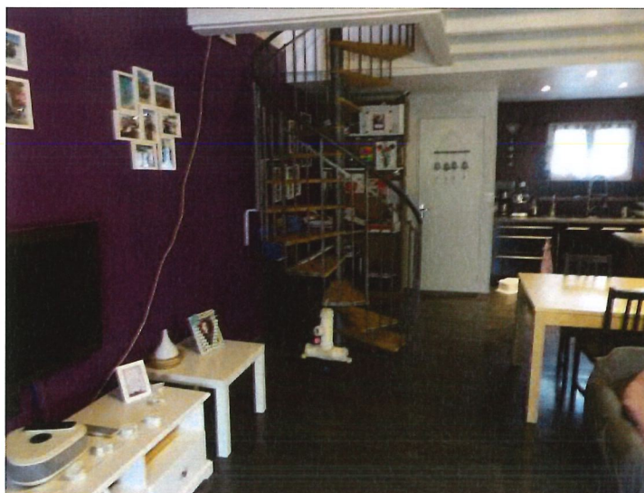
Permettant l'accès à l'étage, un escalier en colimaçon à armatures métalliques et marches bois.
