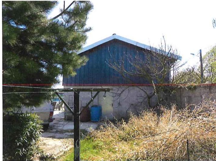
La façade arrière de la grange est composée de béton et d'un bardage en métal.
