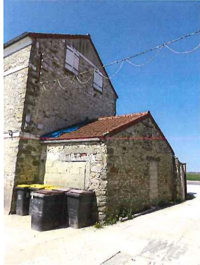
La façade arrière de la maison est composée de pierres jointoyées et de parpaings jointoyés. Certains éléments de la façade sont recouverts d'un enduit. Fixé en applique, un store-banne.
