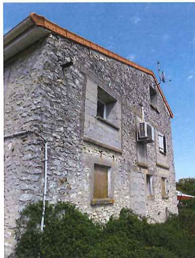
Le mur pignon gauche de l'édifice est composé de pierres jointoyées et de parpaings jointoyés.
