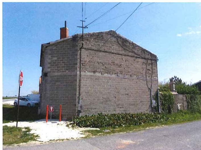
Le mur pignon gauche de l'édifice est composé de pierres jointoyées et de parpaings jointoyés.
