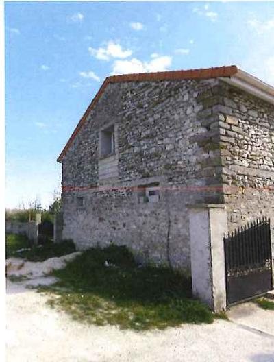
La façade arrière de l'immeuble est composée de pierres jointoyées et de parpaings jointoyés. Au premier étage, une terrasse en béton ceinturée par des parpaings jointoyés et un escalier d'accès en béton.
