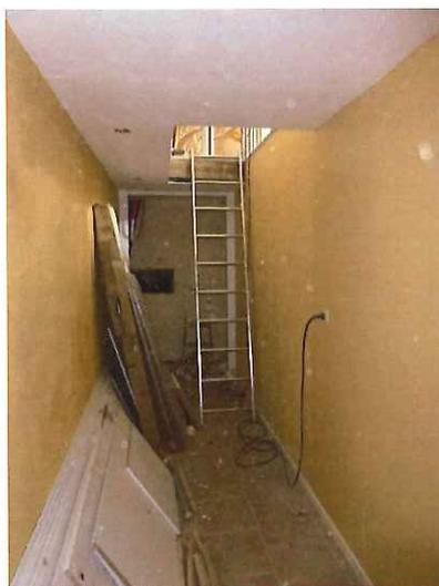
Le second étage est en travaux. Le plancher est à l'état brut. Les cloisons sont en cours de réalisation.
