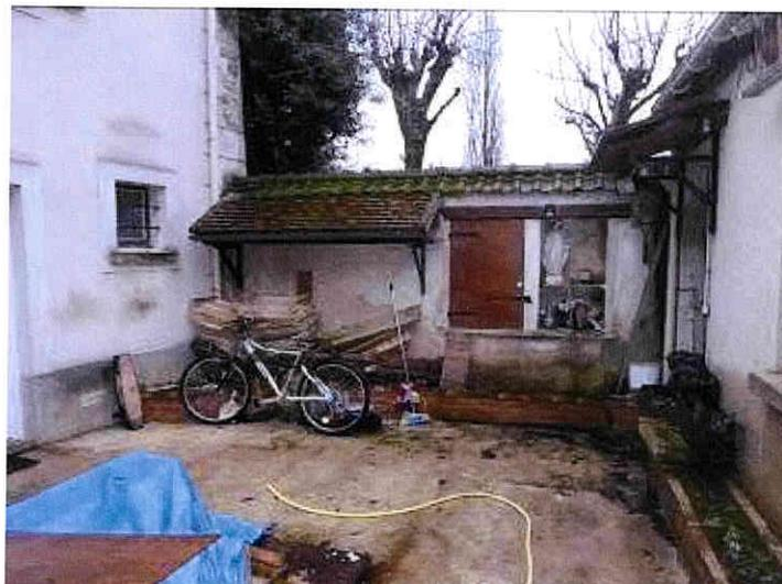
En partie gauche, un mur recouvert d'un enduit avec chaperon en béton assure la séparation du fonds.
